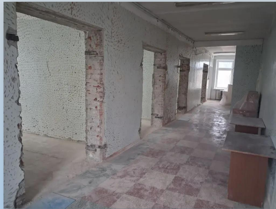
Ремонт помещений ДМШ, 2026 г.
