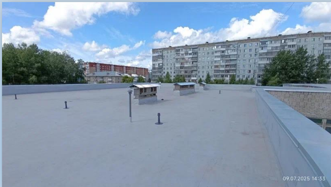
Кровля ДМШ после ремонта, 2025 г.
